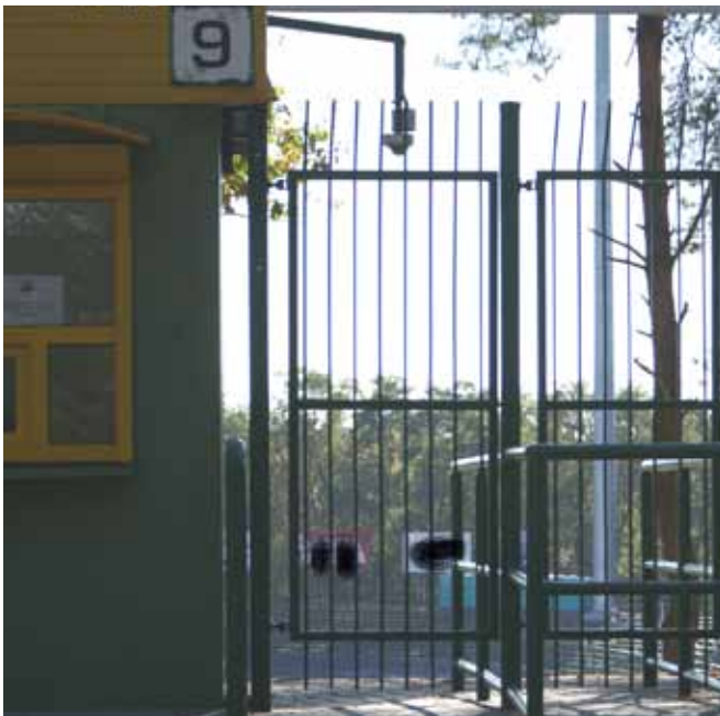
Rys. 12. Widok kasy z zamontowaną kamerą
